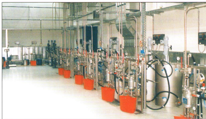
Inrichting verfmengruimte in een autobiefabriek.
